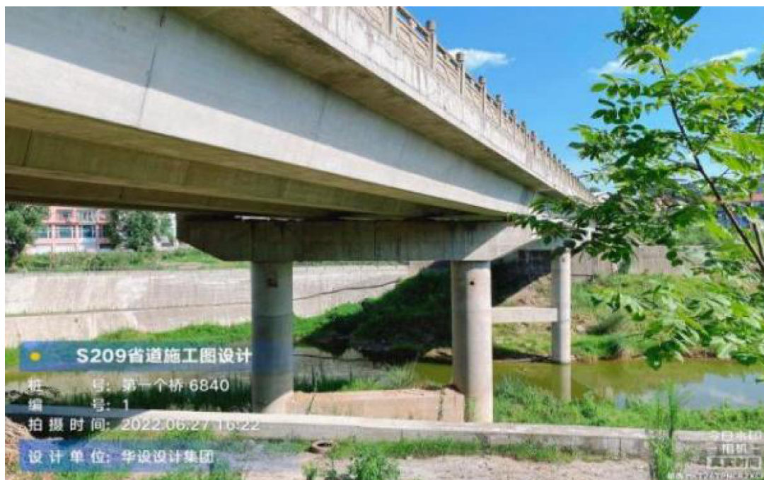
图 2-4 林海大桥现状图
