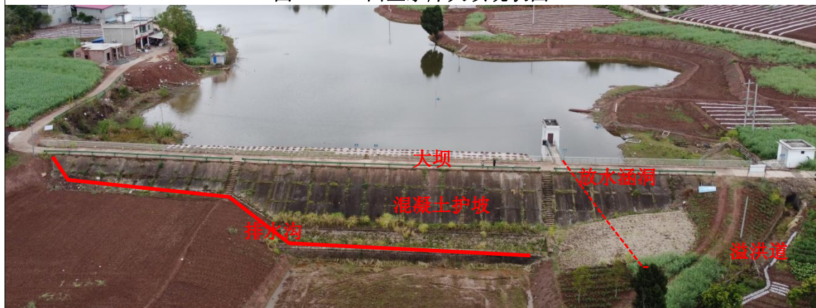
图4-4 青狮水库大坝现状图
