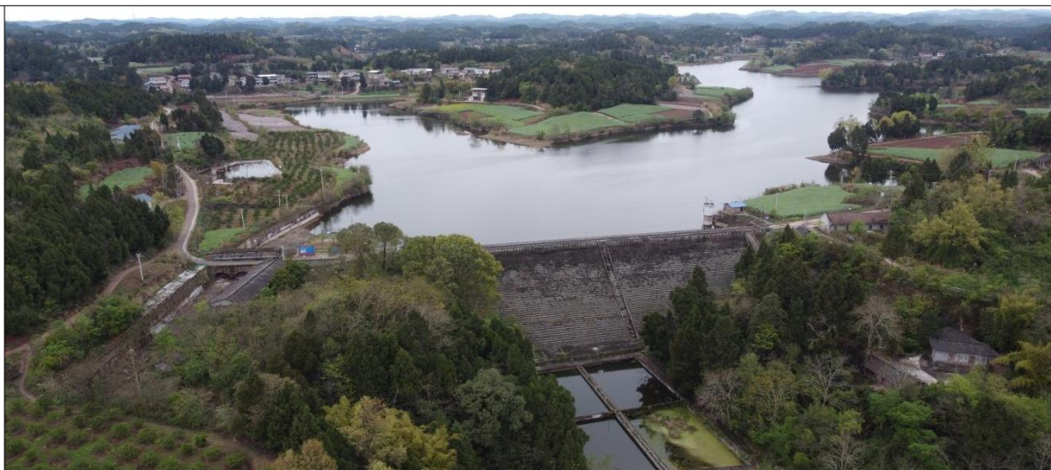
图4-5 四五水库俯视图
