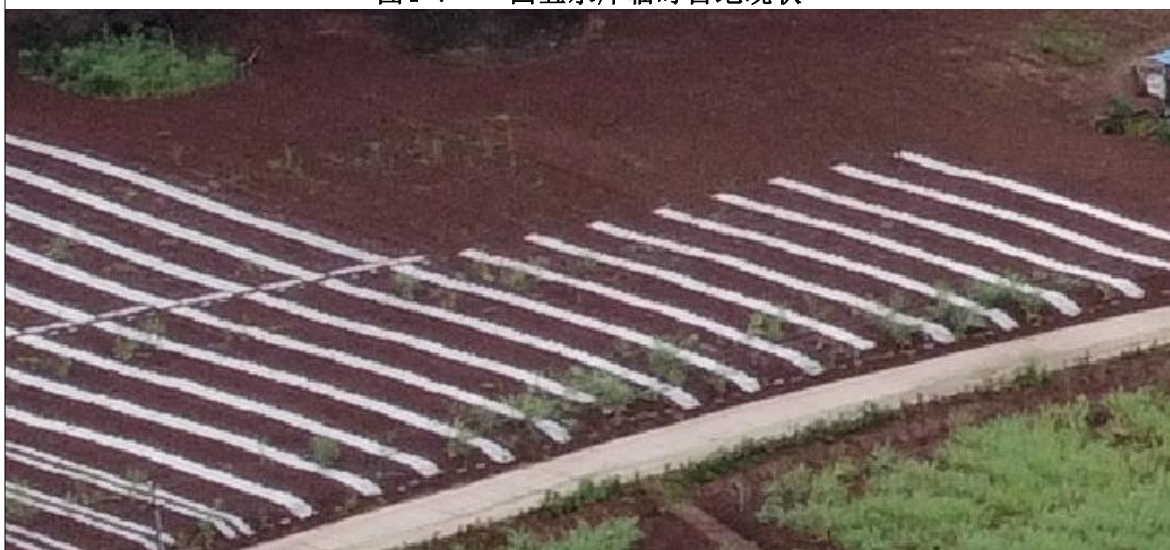
图4-8 青狮水库临时占地现状
