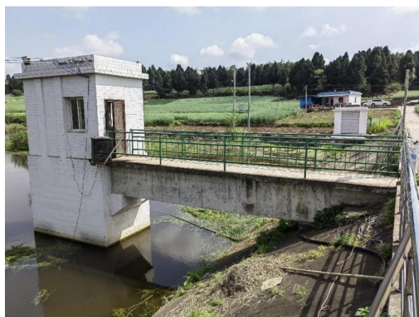
整治前放水设施
